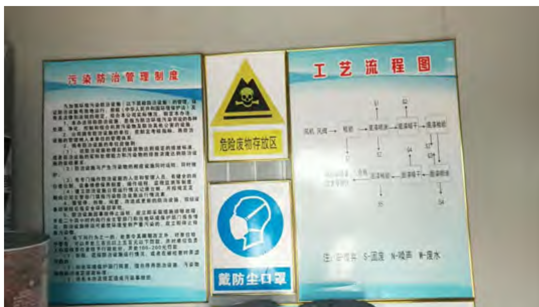
4-2 危险废物暂存间
